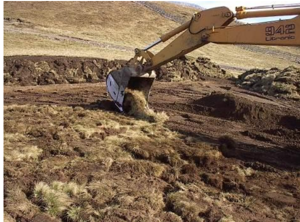
Photo 3 Exemple de remise en place de mottes à la pelle mécanique
