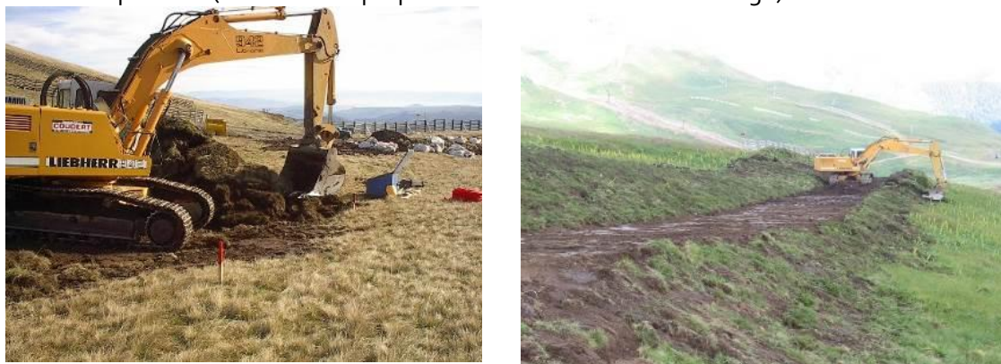
Photo 2 Exemple de stockage de mottes à la pelle mécanique en bordure d'emprise et de remise en place
