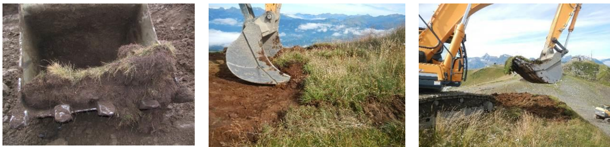
Photo 1 Exemple de délaquage de mottes à la pelle mécanique et godet « classique »
