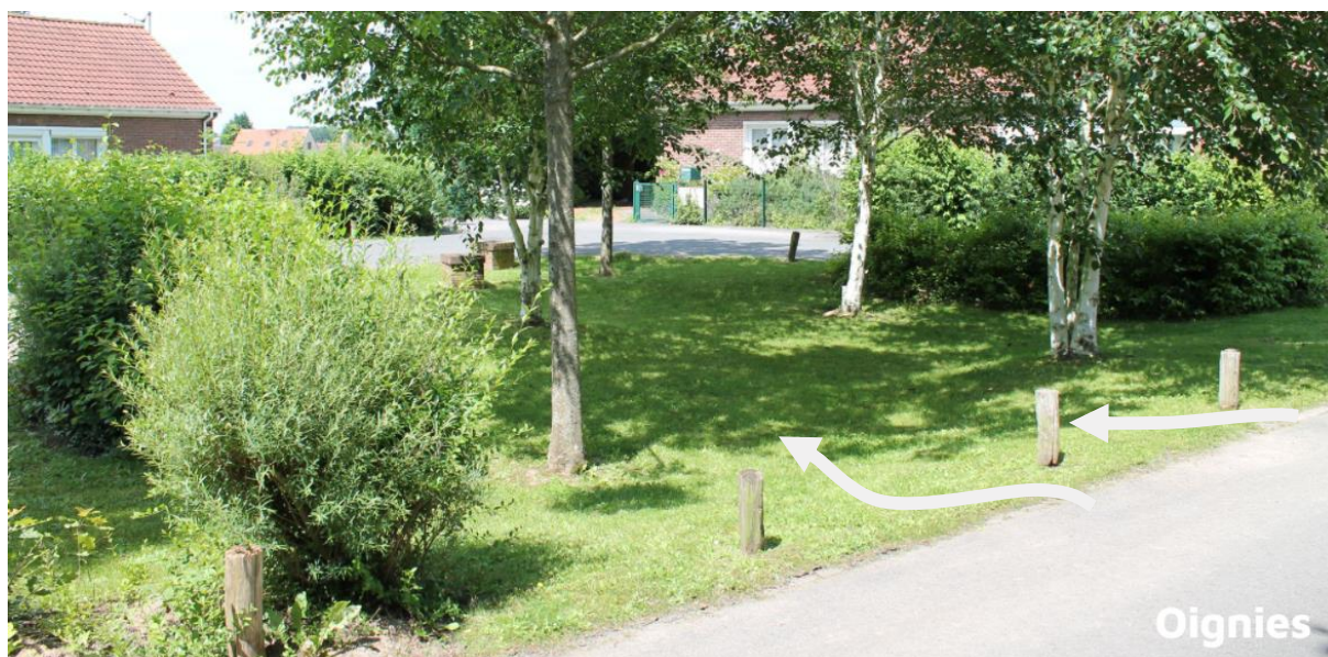
Figure 18 - Espace vert retravaillé en creux, pour gérer les eaux pluviales – Source ADOPTA
