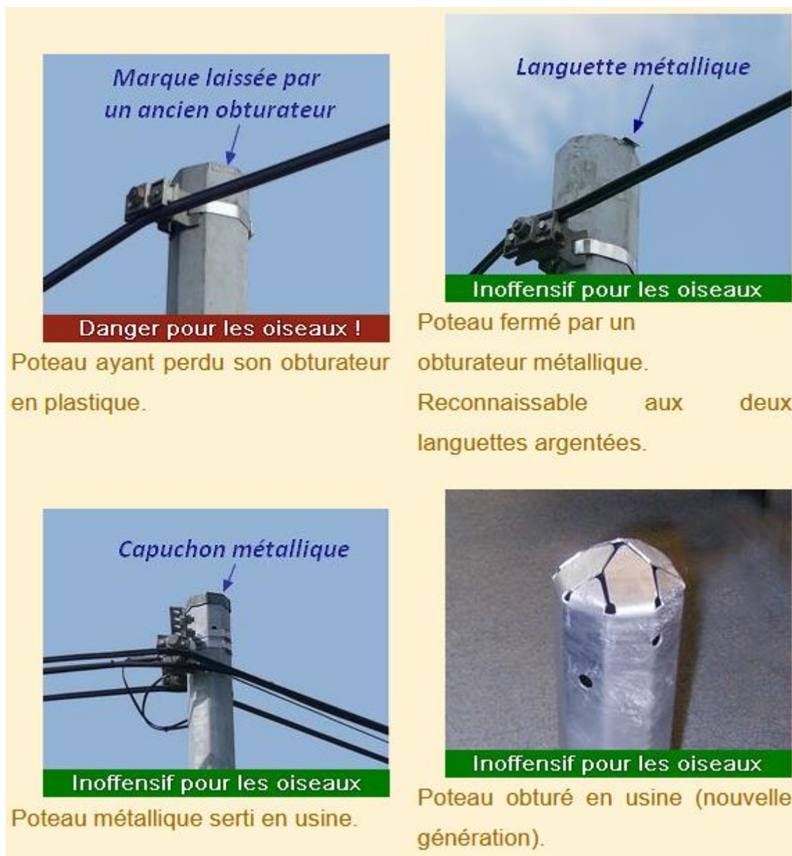
Figure 33 : Exemple de poteau obturé pour limiter la mortalité de la faune
