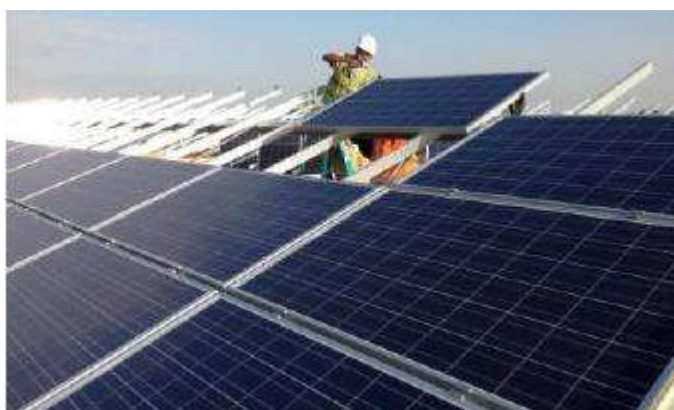
Figure 28 – Photographie pose des panneaux sur les supports
