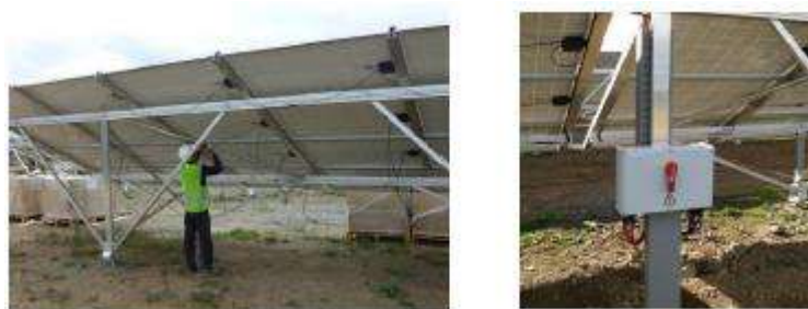
Figure 30 – Photographies du câblage des panneaux (gauche) et du boîtier de raccordement (à droite)
