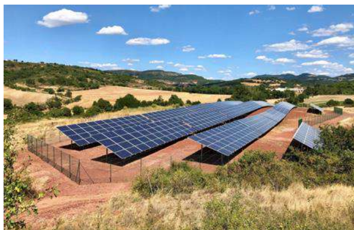
Figure 24 - Exemple de structures fixes (Parc solaire de 249 kWc à Lagarde à Camares dans l'Aveyron (12) d'Enercoop Midi-Pyrénées sur une ancienne décharge
