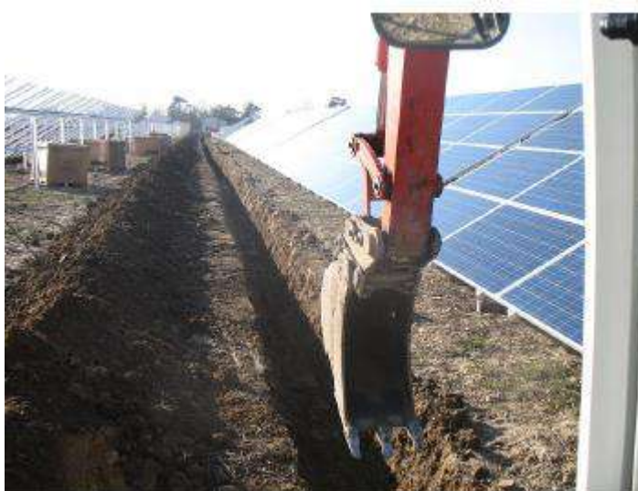
Figure 29 – Tranchée pour le passage des câbles
