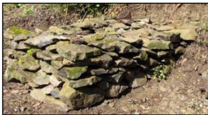
Illustration 6 : Exemple de muret de pierres sèches. Source : Daniel Guérineau.
