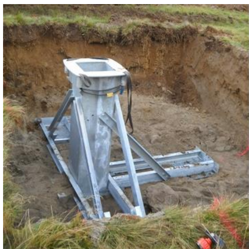
Photo 12 Embase métallique de pylône
