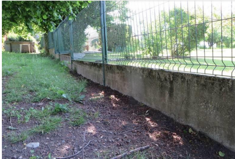
Photo 30 : Exemple de muret et clôture infranchissable par la moyenne faune (hérissons, etc.) au sud des parcelles 1472, 1471, 1470
