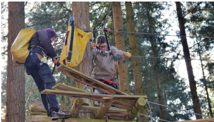
Démontage de parcours acrobatiques par des professionnels formés au travail en hauteur
