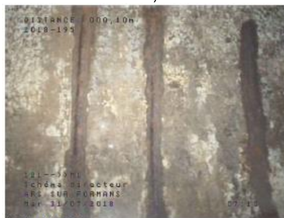
Armatures visibles dans la conduite principale, ZOOM (121-M1)
