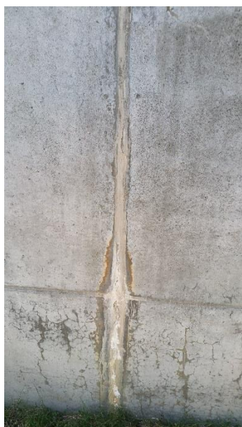
Quelques fissures avec concrétion sont visibles au niveau du bassin d'aération
