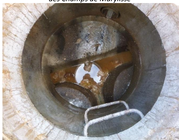
Dépôts et stagnation d'effluents – Regard 265 – Lotissement des Troènes
