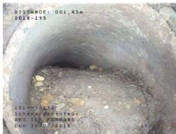
Conduite de branchement obstruée (Rue du Carmel, 131-132)
