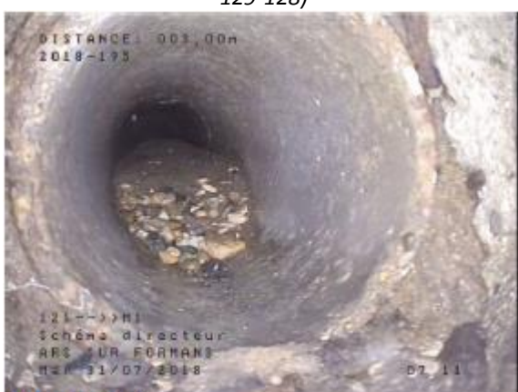
Conduite de branchement obstruée (Hypercentre, 121-M1)
