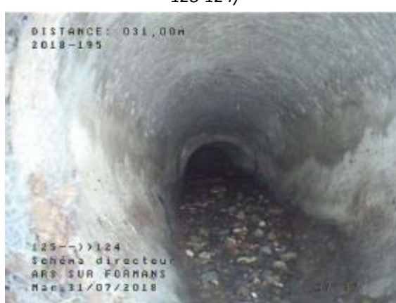
Conduite de branchement obstruée (Hypercentre, 125-124)
