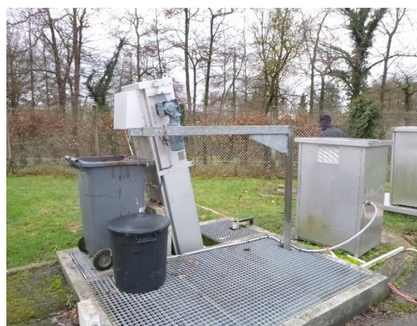
Dégrilleur automatique, poste de relevage, préleveur d'entrée
