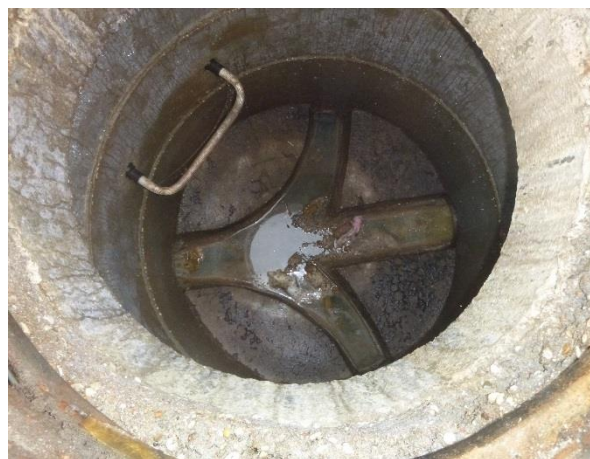
Dépôts et stagnation d'effluents – Regard 111 – Allée des Champs de Marylisse
