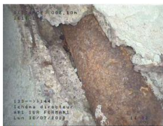
Conduite, à priori métallique, traversant la canalisation unitaire, risque d'éclatement des bétons
