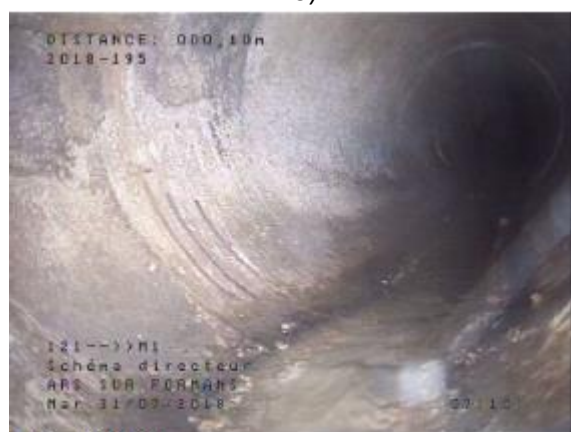
Armatures visibles dans la conduite principale (121-M1)
