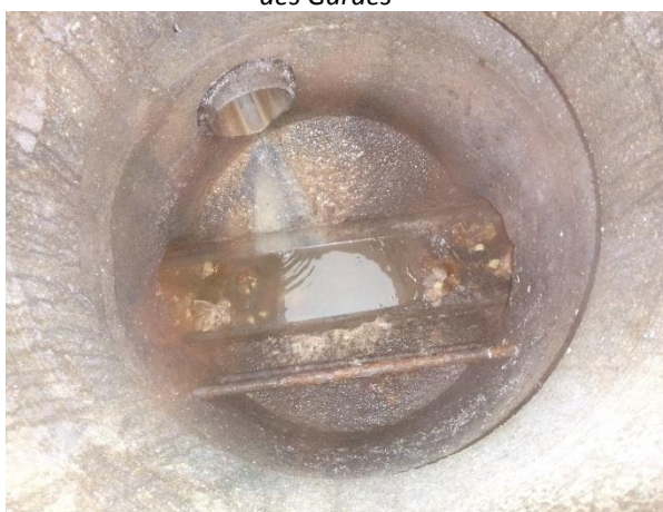
Dépôts et stagnation d'effluents – Regard 103 – RD904
