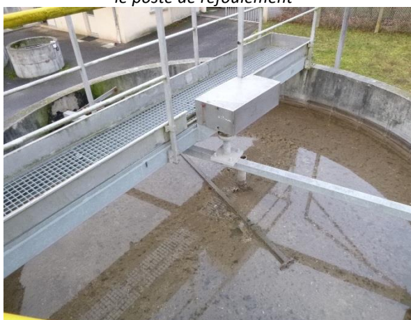
Dégraisseur dessableur avec aéroflot
