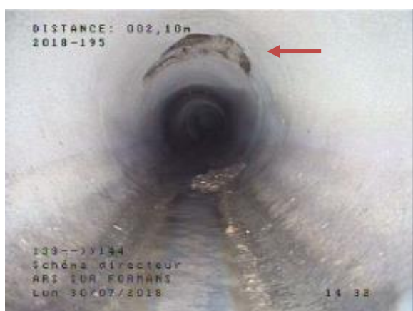
Rupture, effondrement partiel, lié à un passage d'une conduite (144-133), matériaux excavés visiblement en radier, après curage
