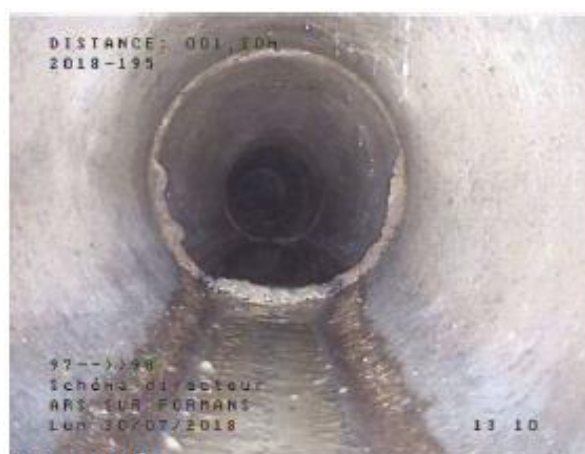
Concrétions au droit d'un emboîtement (97-285)
