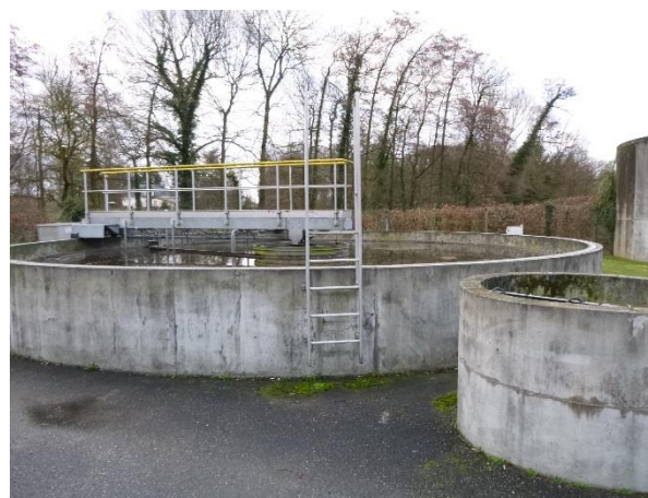
Clarificateur et poste de recirculation, quelques fissures sont également présentes sur le clarificateur, des traces de bactéries filamenteuses sont visibles au niveau de la goulotte.
