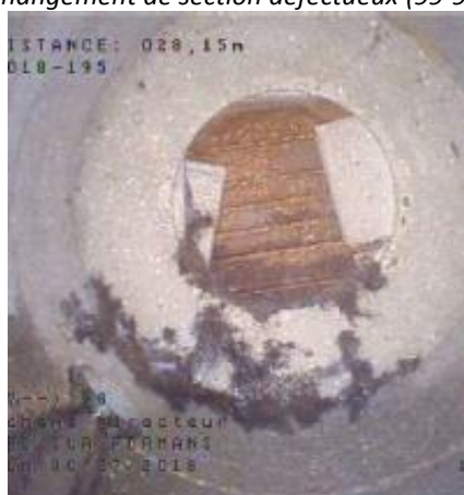
Racines au droit du regard 285, nouvellement identifié (base de données mise à jour en conséquence)
