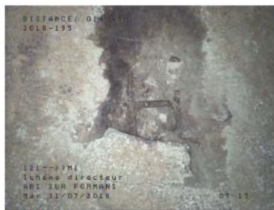
Armatures visibles dans la conduite principale (121-M1)
