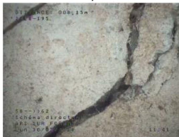
Fissure hélicoïdale ouverte (60-58)
