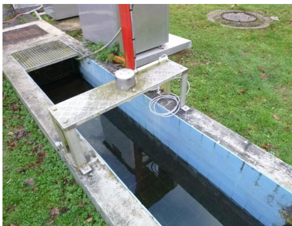
Canal de sortie, sonde US, préleveur. La sonde US n'est pas protégée du soleil ni du vent, elle est également trop proche du seuil.
