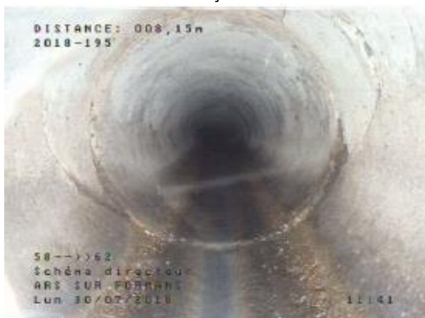
Fissure hélicoïdale ouverte (60-58)
