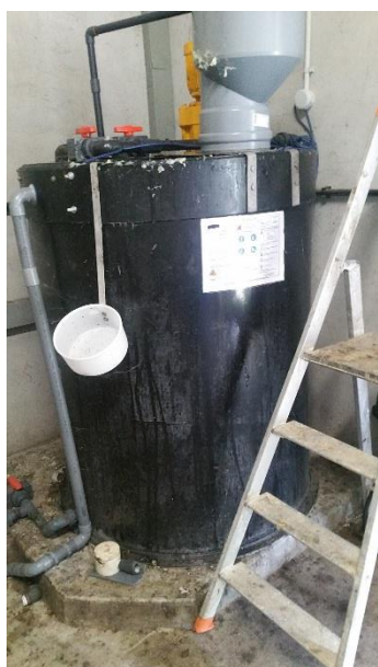
Cuve de stockage du polymère
