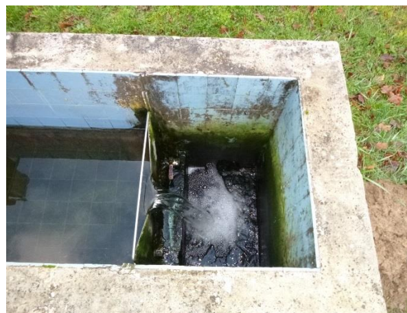
Canal de sortie. Au vu des débits rencontrés, la hauteur de pelle semble insuffisante, l'écoulement n'est pas toujours libre à l'aval du seuil.
