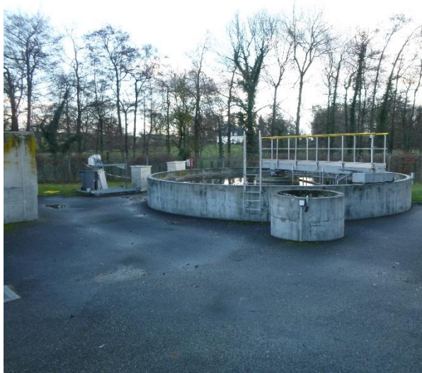
Clarificateur avec pont racleur
