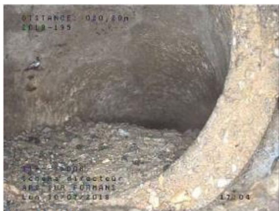
Conduite de branchement obstruée (Rue du Tonneau, 51-DO8)
