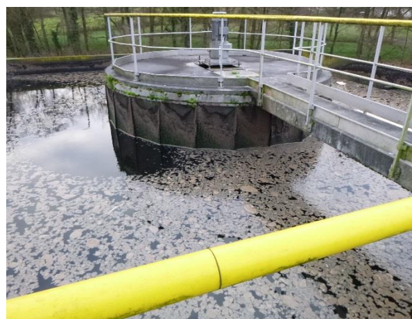
Bassin d'aération carré avec turbine pour aération et brassage. Lors des phases d'aération, le brassage semble homogène.
