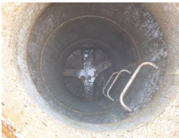
Dépôts et stagnation d'effluents – Regard 141 – Allée des Gardes
