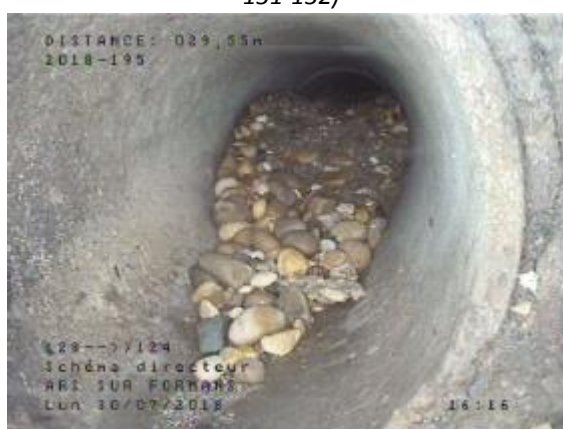
Conduite de branchement obstruée (Rue du Carmel, 128-124)
