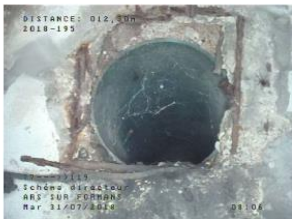
Armatures visibles au droit d'un raccordement (77-119)
