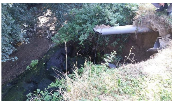
Rejets au Formans (eaux traitées et eaux déversées par le DO3), effondrement important en cours.
