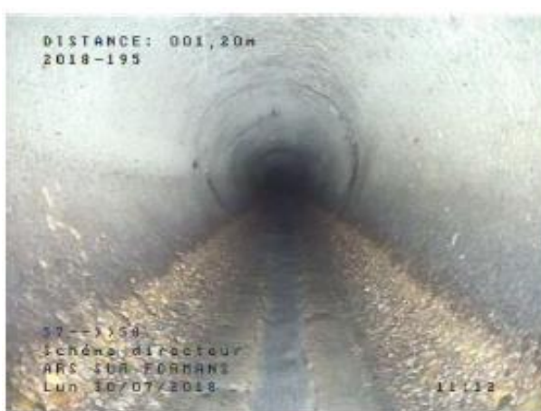
Rugosité accrue de 4 à 8h sur quasiment la totalité du tronçon
