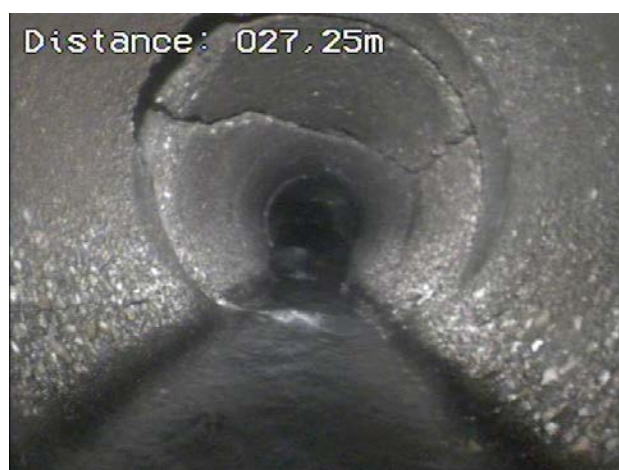
Rupture/Effondrement R67 vers R66-R204
