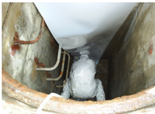
Mise en place du liner
