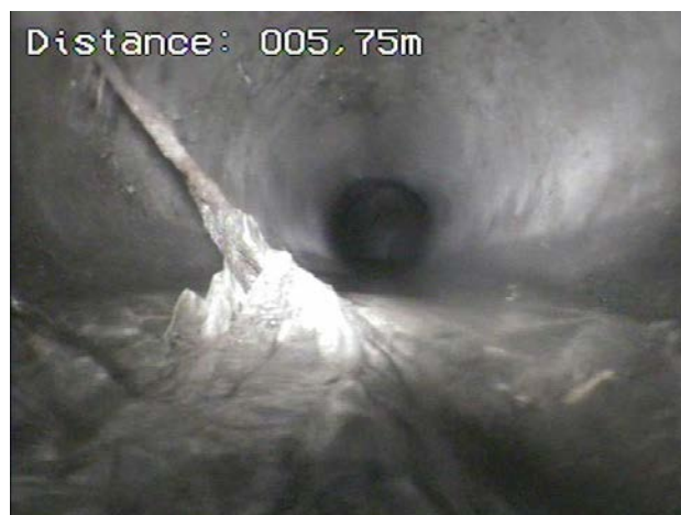
Obstacle coincé dans l'assemblage R52 vers R56
