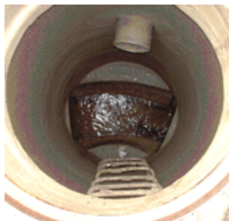
Ragréage de regards de visites par application d'un mortier
