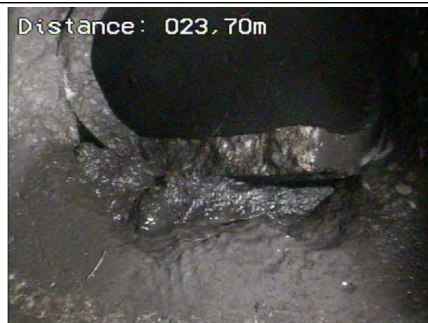
Raccordement buriné piquage direct R45 vers R44
