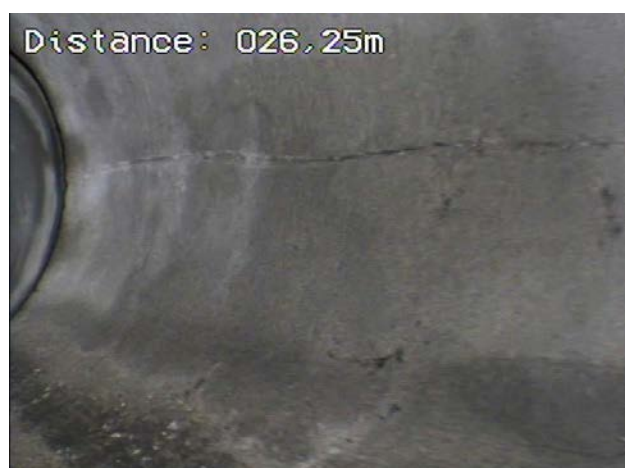
Fissure longitudinale R50 vers R39
