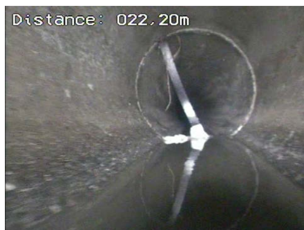
Joint d'étanchéité apparent
