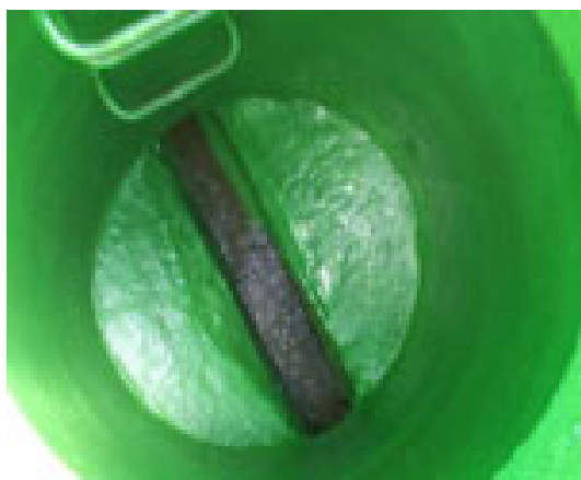
Ragréage de regards de visites par projection de résine
