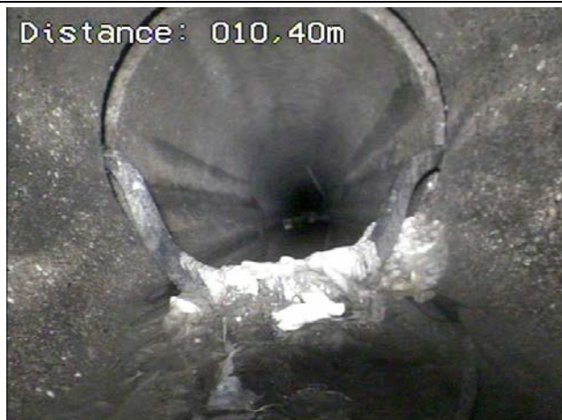
Joint d'étanchéité apparent pénétrant mais non rompu R50 vers R51
