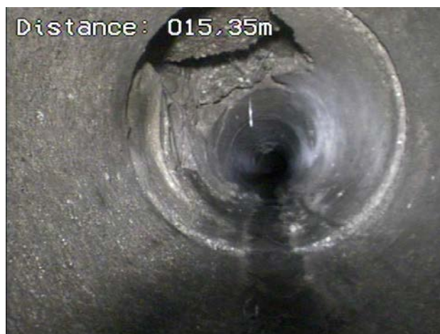
Rupture / Effondrement partiel R69 vers R69 bis
