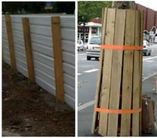
Exemple de protection installées en phase de chantier pour la préservation des arbres - Source : BDP Concept, février 2022
