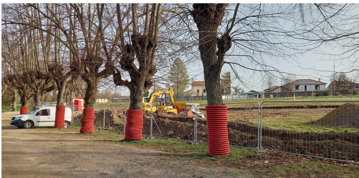
Figure 26 : Illustration d'un balisage (barrière Heras) et de gaines PVC autour de troncs d'arbres © EODD, 2021
