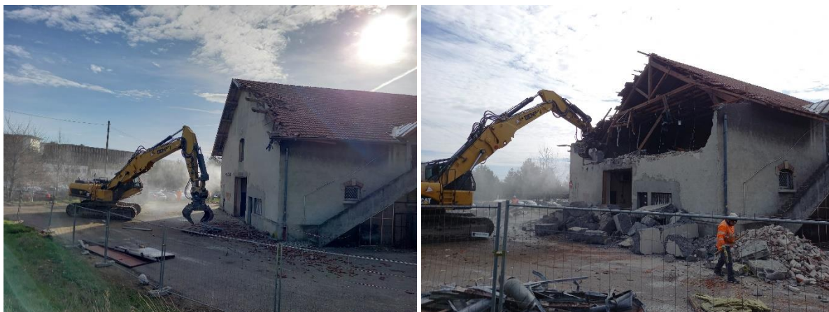
Figure 28 : Illustration de la démolition progressive d'un bâtiment (chantier du Vallon des Hôpitaux) © EODD, 2021
