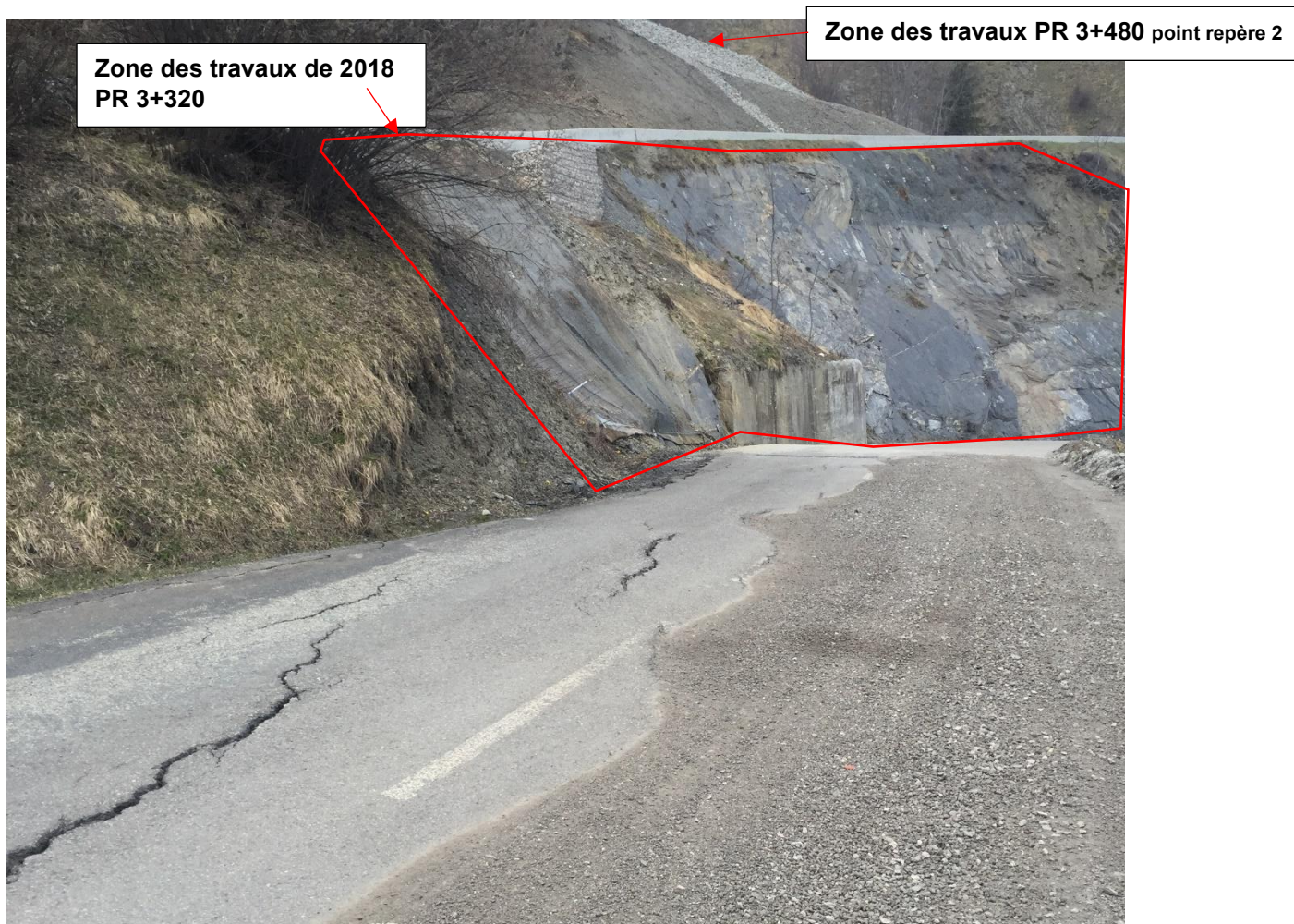
Photo 6 : repère 6 sur la figure 1 chaussée RD78A fissurée.
