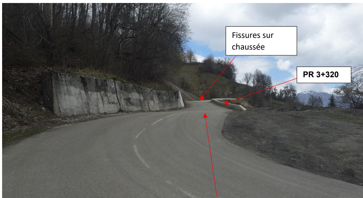
Photo 5 : repère 5 sur la figure 1 mur amont fissuré déformation de la chaussée
