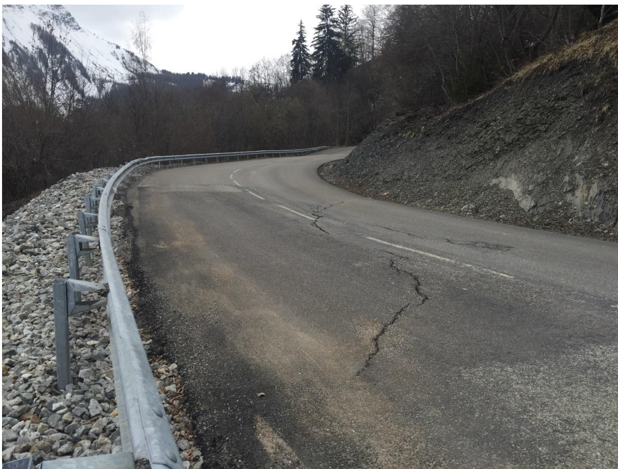
Photo 2 : Fissure sur chaussée RD78A PR 3+480 point repère 2 sur la figure 1
