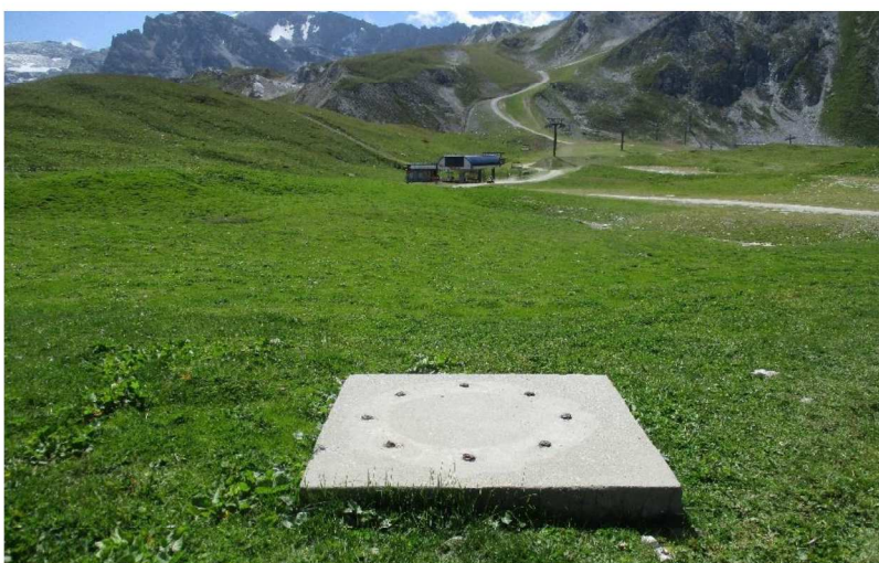
Vue vers le Sud dans l'axe du projet dans la traversée des zones pastorales. Présence d'un ancien socle de pylône de remontée mécanique présent et qui devrait disparaître dans le cadre des terrassements liés au futur projet.
