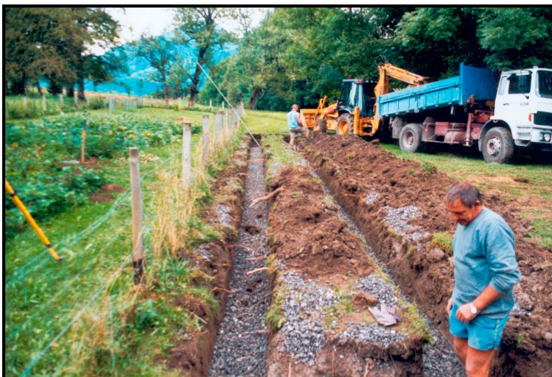
Tranchées d'épandage en cours de réalisation
