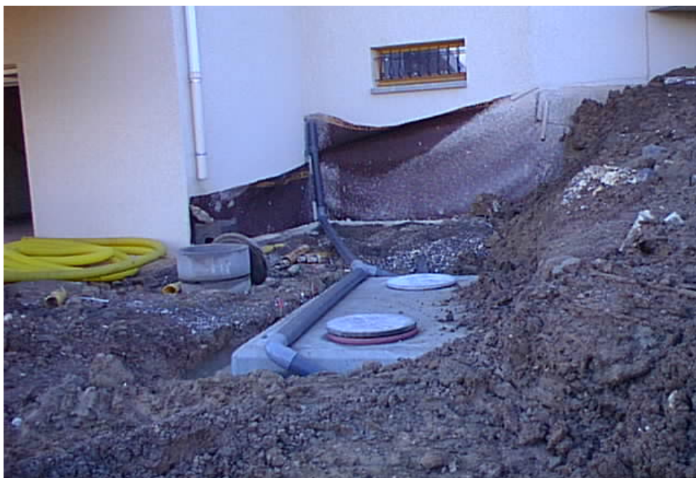
Fosse septique toutes eaux et ventilation secondaire
