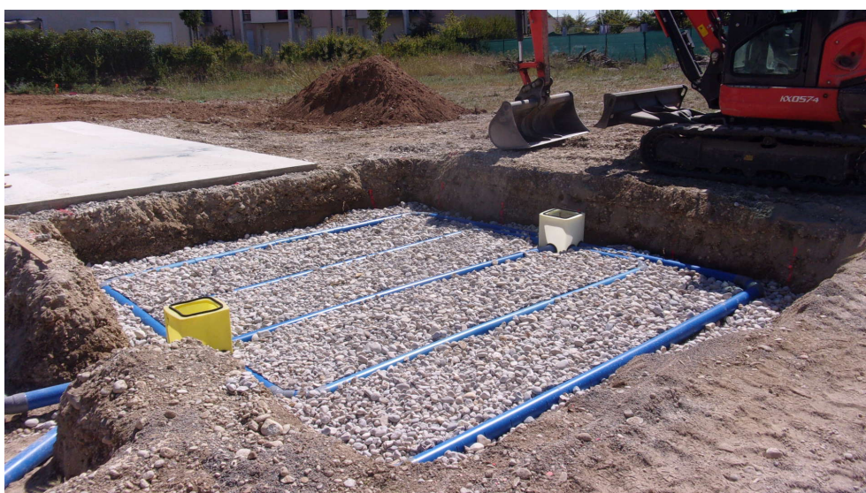
Filtre à sable vertical non drainé en cours de réalisation
