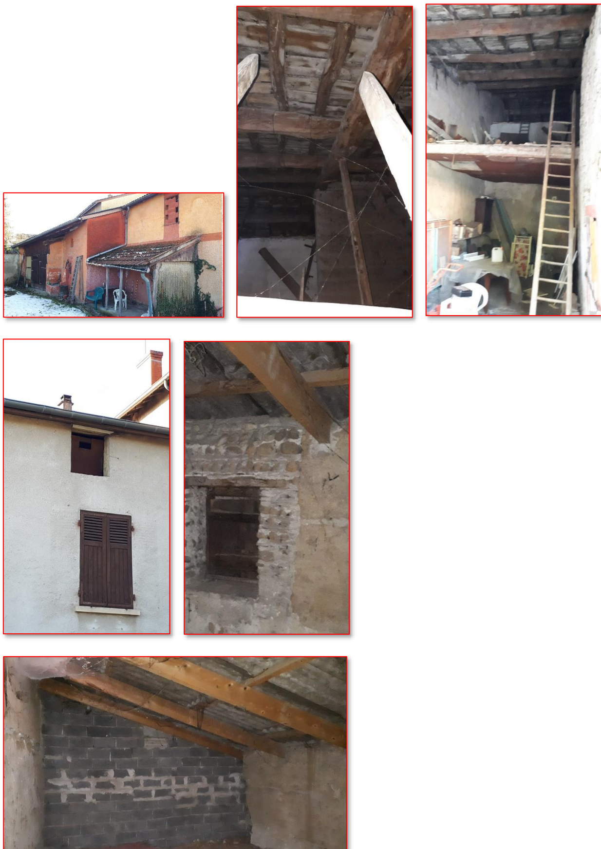
Figure 18 - Analyse intérieurs des bâtiments à enjeux : ouverture et pas d'isolation (toiture fibrociment), accessibilité à la prédaction, pas de fissures ni de caches, pas d'indices de présence
