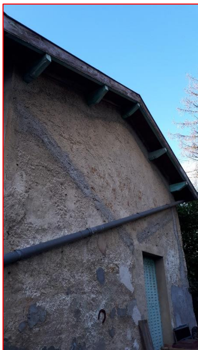
Figure 17 - Analyse extérieur des bâtiments : pas d'éléments particulier : pas de fissures suffisamment marquées, coffre de volet roulant extérieur non isolé, pas de bouche d'aération sans grille,....
