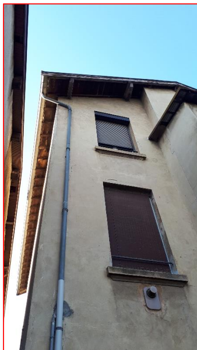
Figure 17 - Analyse extérieur des bâtiments : pas d'éléments particulier : pas de fissures suffisamment marquées, coffre de volet roulant extérieur non isolé, pas de bouche d'aération sans grille,....
