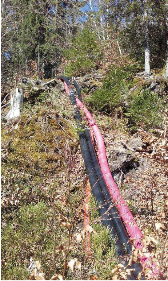
Photo 3 Prise de vue 3 - Canalisations aériennes entre la prise d'eau et la salle des machines. (Source : Agrestis)
