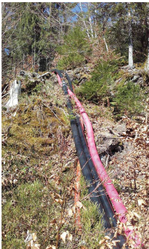
Photo 2 Canalisations aériennes entre la prise d'eau et la salle des machines. (Source : Agrestis, avril 2019)
