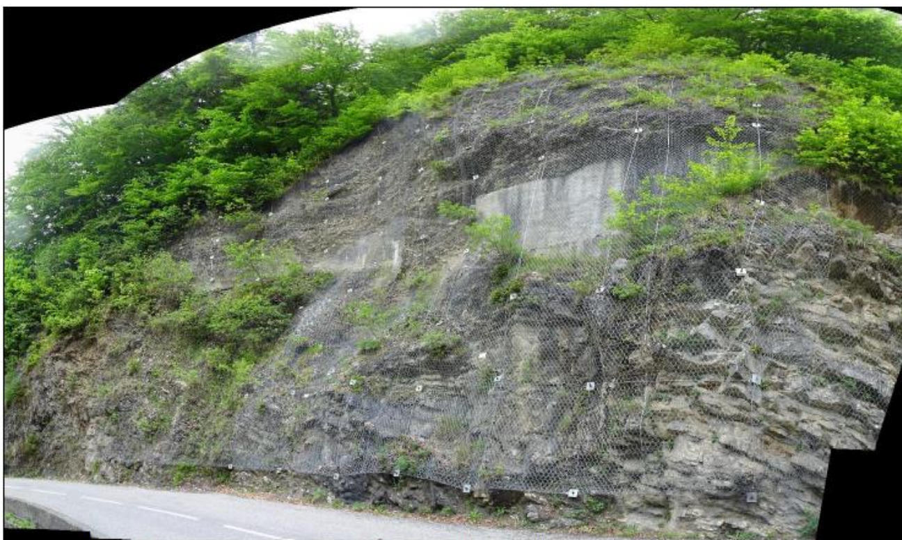
PR23+280 environ – grillage plaqué avec le buton en béton et les zones de béton projeté
