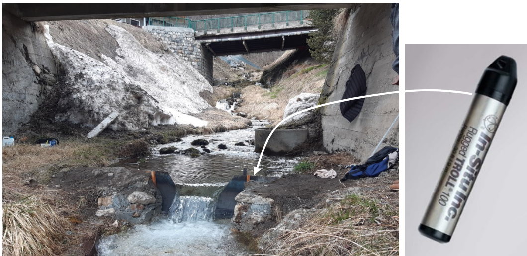
Figure 6 - le seuil installé sur le Remous / sonde piézométrique enregistruse
