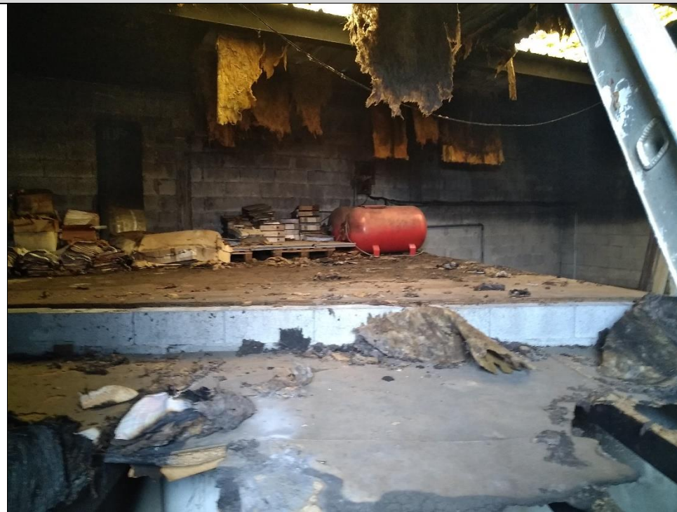
Au-dessus des sanitaires et du magasin d'outillage, une remise est également observable avec la présence de deux cuves, probablement à air comprimé. Traces de combustion et d'infiltration d'eau.
