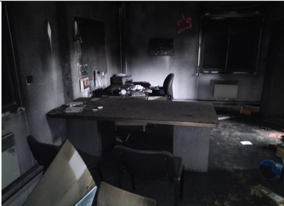
Observation de l'intérieur du bureau. La pièce ne semble pas avoir subi d'incendie mais de la suie noire semble s'être déposée, recouvrant toute la surface.
