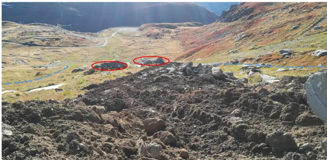
Photo 3 : Vue rapprochée du terrassement non achevé de la partie basse qui nécessitera de briser 3 blocs rocheux tout en évitant les rus temporaires actuellement à sec
