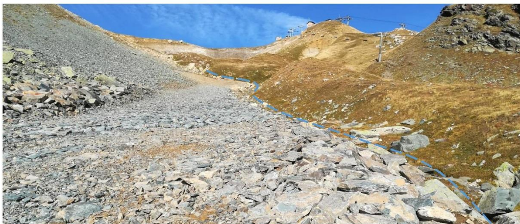
Photo 6 : Terrassement achevé de la partie amont et n'ayant pas impacté le ru à sec (à droite) vu depuis l'aval
