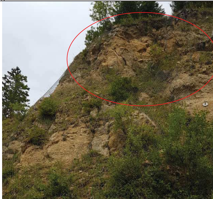
Figure n°8 – visualisation des masses instables en tête de talus
