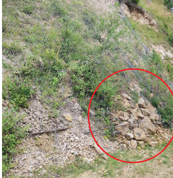
Figure n°7 – visualisation de pierres accumulées sous le grillage en pied de talus
