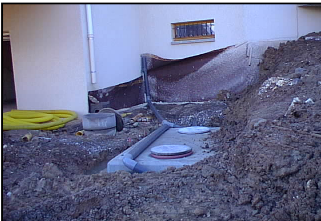
Fosse septique toutes eaux et ventilation secondaire
