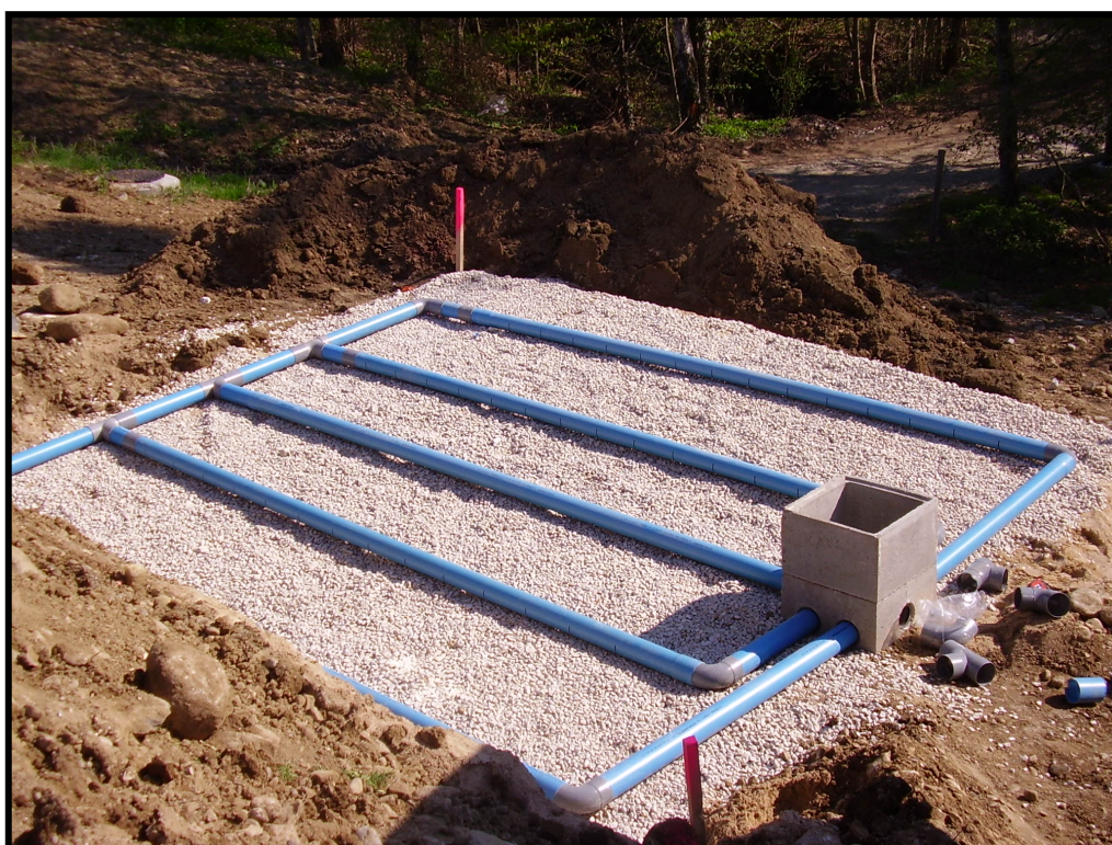
Filtre à sable vertical non drainé en cours de réalisation
