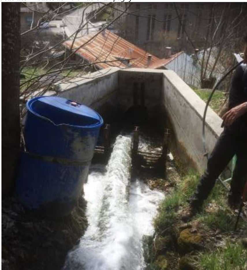
Photo 2 Entrée de la canalisation béton actuelle conduisant l'eau des Airollées au Doron de Champagny
