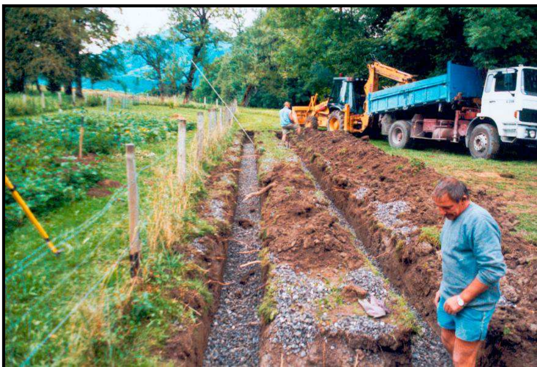
Tranchées d'épandage en cours de réalisation
