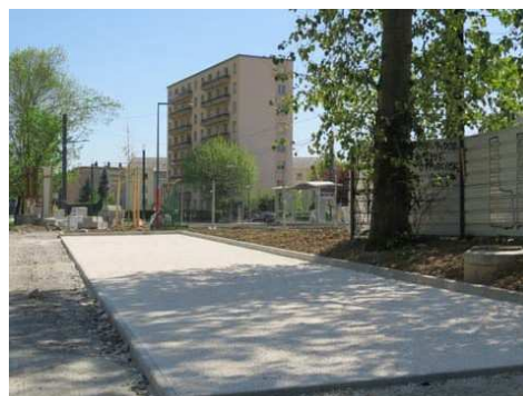
Exemple d'un aménagement de parking en cour de réalisation avec le procédé NIDAGRAVEL et un remplissage de gravier concassé calcaire blanc
