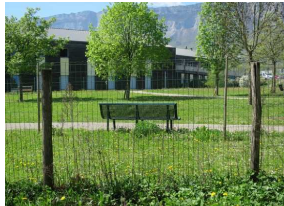
La clôture existante constituée de poteaux bois - hauteur environ 1.50 m avec grillage rigide à maille rectangulaire
