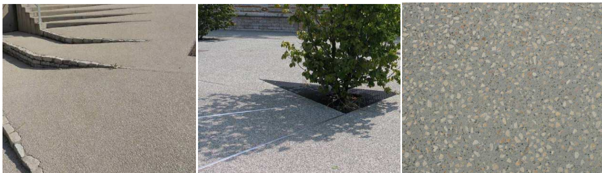
Exemples de différents types de revêtements en béton désactivé et/ou sablé
