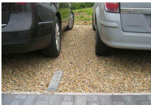
Exemple d'un aménagement de parking réalisé avec le procédé NIDAGRAVEL et un remplissage de gravier coloré
