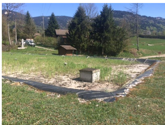
1 er étage filtre plantés de roseaux
