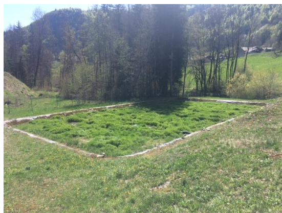
2 nd étage filtre plantés de roseaux
