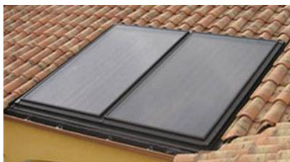
Exemple de panneaux solaires thermiques
