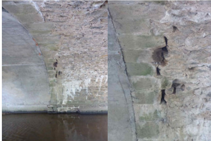
Fissures dans l'ouvrage de franchissement du ruisseau
