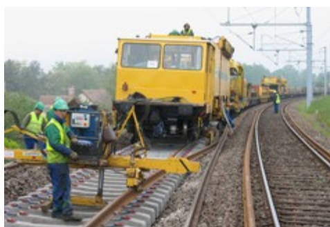
Longs Rails soudés sur traverses béton
