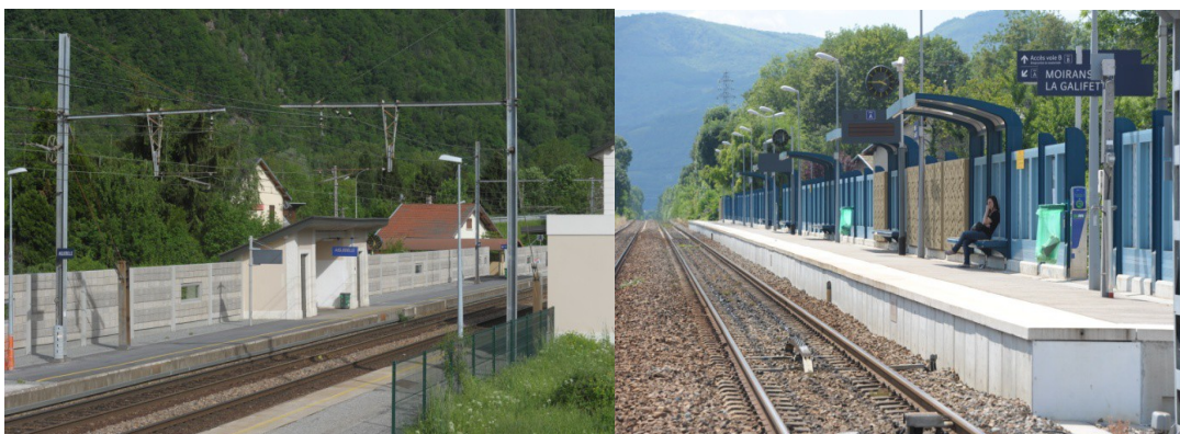
Exemples d'écrans acoustiques à Aiguebelle et Moirans
