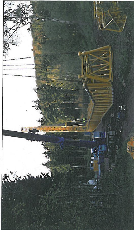
Montage au sol de la flèche en treillis de la grue (que dans le cas d'utilisation de ce type de grue)
