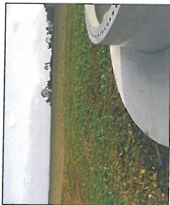
Bord de la fondation recouvert de terre végétale et cultivable
