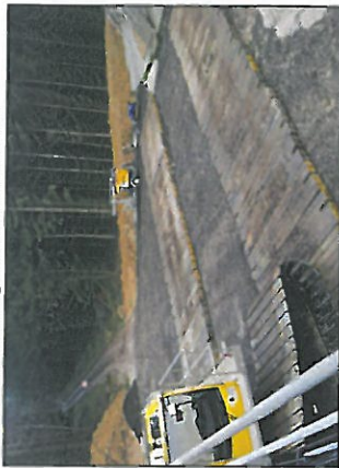
Protection du sol sous les chenilles des engins de chantier
