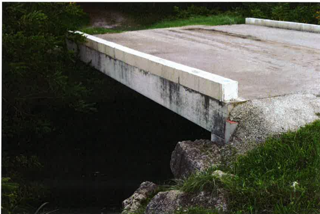
4.Etat projeté – modèle de pont cadre envisagé (ici sur la lône Dion - commune Pierrelatte)
