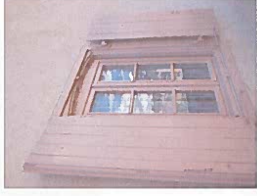
Cadre de menuiserie en bois mouluré à arc segmentaire
