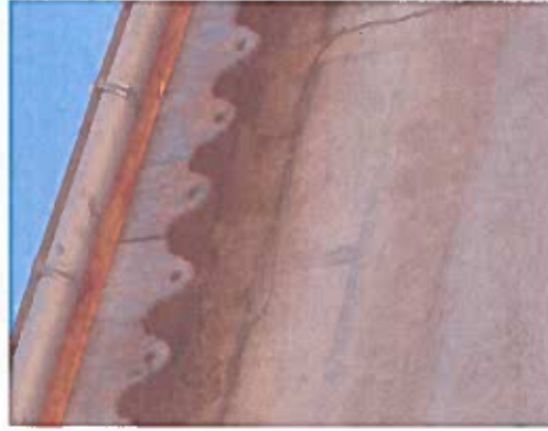
Enduit à décors - faux appareillage
