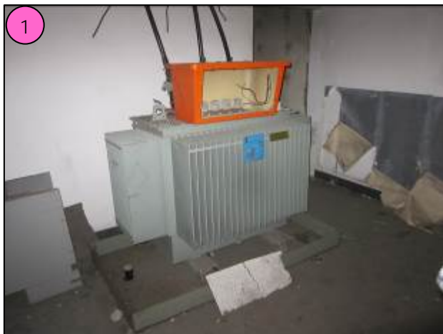
Poste transformateur PCB
