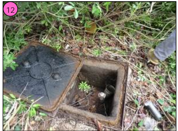
Regard d'une cuve de fioul enterrée de 10 m 3 sur le site Billon Frères
