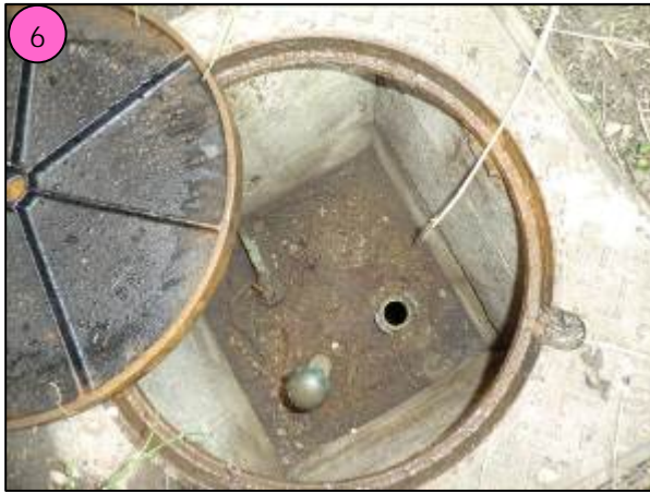
Regard de la cuve enterrée de fuel de 3 m 3 chez Mme Pequay
