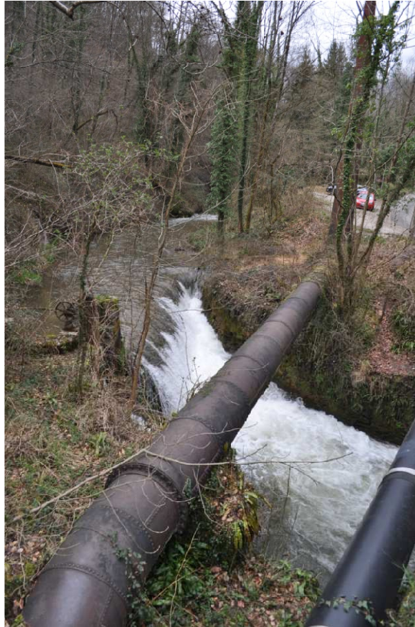
Photographie 5 - Conduite forcée et seuil dans le tronçon court-circuité Photographie prise le 31 mars 2015
