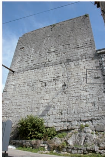
Disparition des chaînages et reconstruction du mur est du donjon
