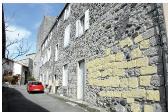
recyclage des blocs/moellons du mur est du donjon, dans les élévations du château moderne
