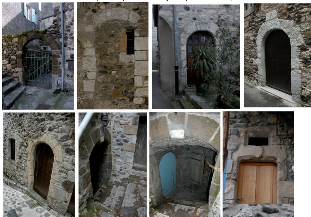
Éléments significatifs de la période médiévale : un ensemble de portes et portails avec arc en plein cintre à claveaux en molasse, grès et calcaire.
