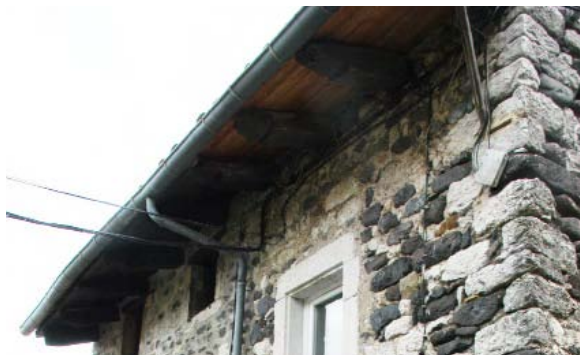
Debords de toit en chevrons de bois dont les extrémités sont taillées en corbeau.
