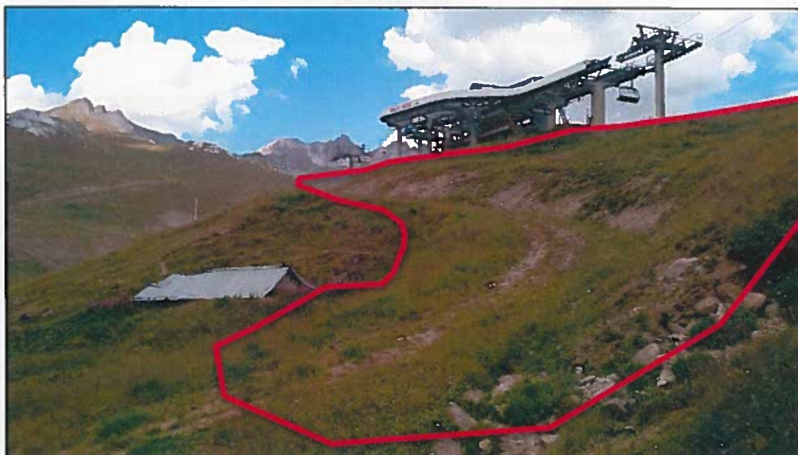
Photo 2 : Déblai et reprofilage du haut de la piste Boïu
