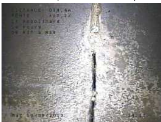
Infiltration et fissures (BOURG - Carrefour)
