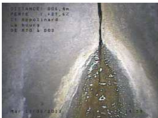
Infiltration et fissures (BOURG - Carrefour)
