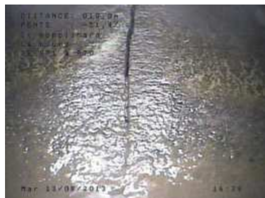
Infiltration et fissures (BOURG - RD)
