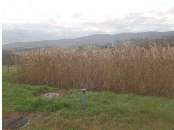
Filtre à sable planté de roseaux
