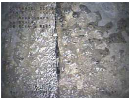
Fissure et infiltration (BOURG - route vers le lotissement du Briat)
