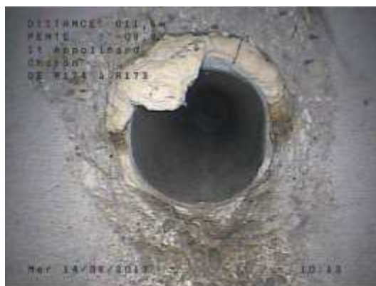
Raccordement par piquage (CHORON)
