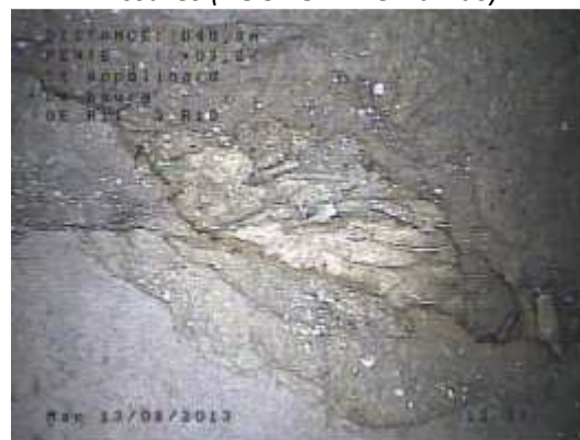
Rupture, effondrement (BOURG – Pré Dumas)
