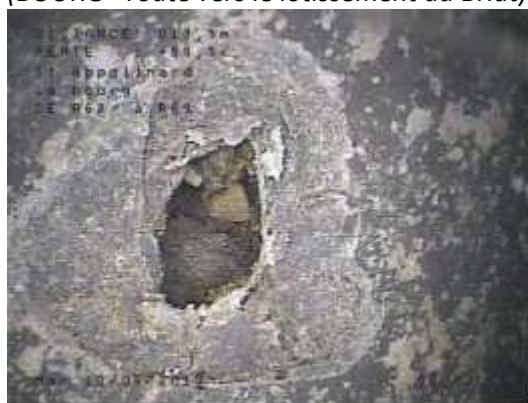
Fissure et infiltration (BOURG - route vers le lotissement du Briat)
