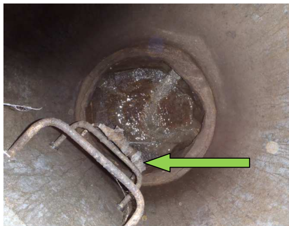
Traces de mise en charge – Le Bourg – Regard 1
