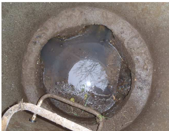
Stagnation des effluents due à la présence d'une planche de coffrage – Le Bourg – Regard 12
