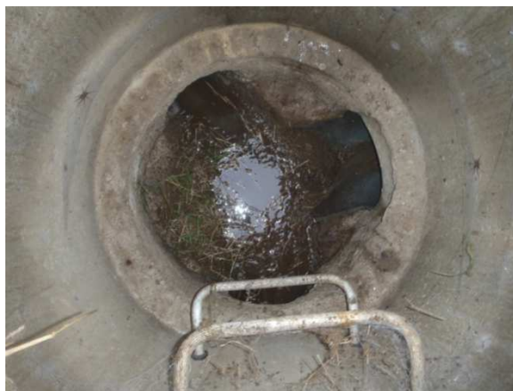
Rejets d'eaux usées par temps sec – Le Bourg – DO RD 503
