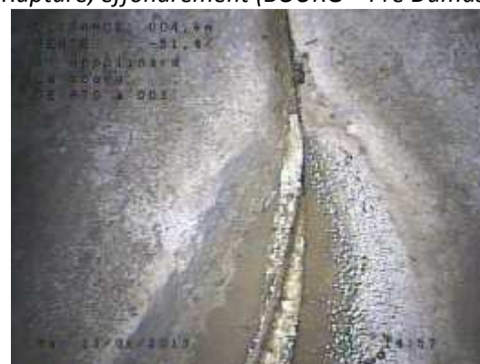
Infiltration et fissures (BOURG - Carrefour)
