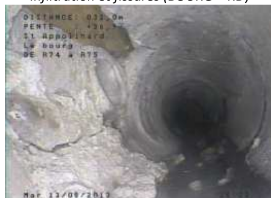
Raccordement par piquage (BOURG - RD)
