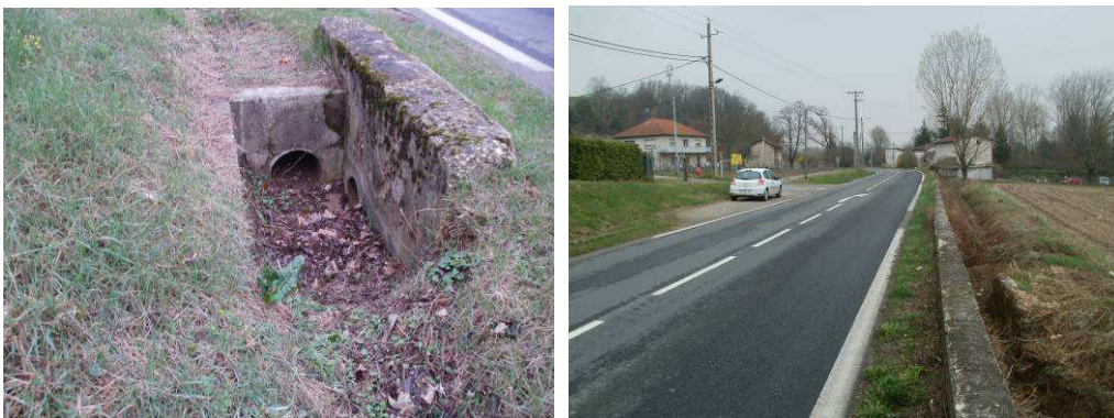
Insuffisance de la capacité de la buse de traversé
