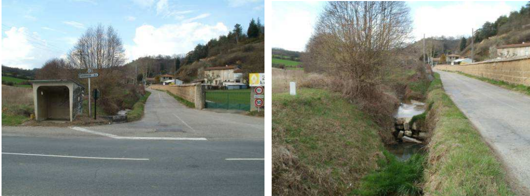
Colmatage très fréquent malgré le piège à sable
