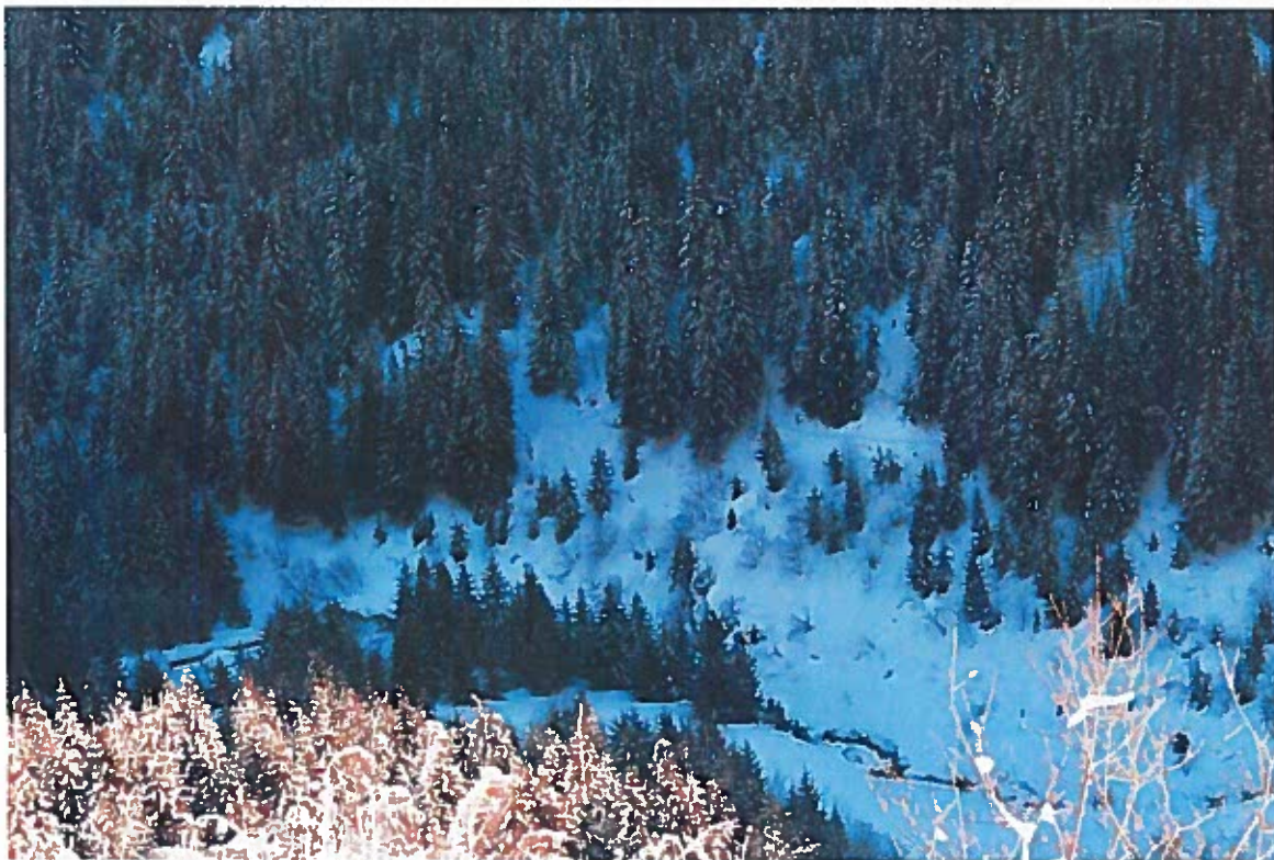
Implantation de la conduite : partie aval, arrivée sur les Chavonnes (le bosquet sombre d'épicéas en bas qui longe le torrent au centre de l'image masque la prise d'eau EDF)
