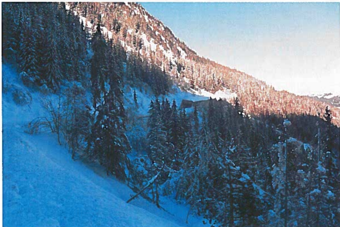
Implantation de la conduite : tronçon en limite de forêt sous la RD avant le paravalanche de la RD
