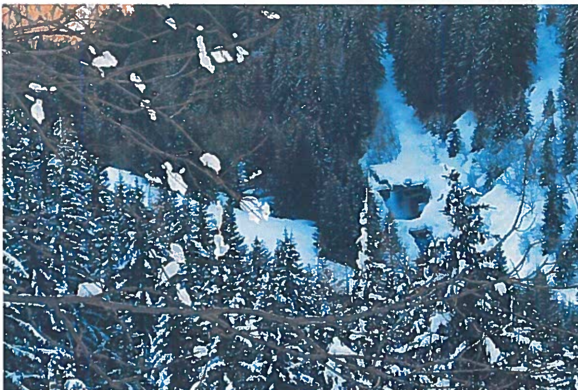
L'usine est prévue à proximité d'une piste existante à la cote 1620 m environ, à l'amont de la prise d'eau EDF sur le Pissevieille (vue depuis la RD)
