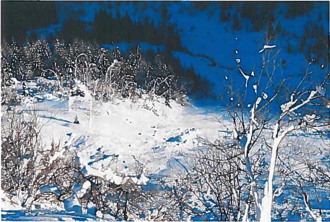
Implantation de la conduite : tronçon en traversée sous le paravalanche de la RD
