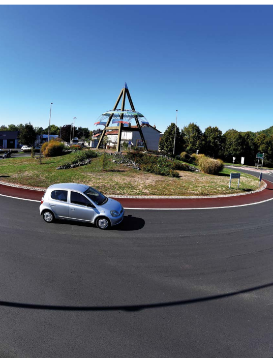
Chaussée neuve sur le giratoire René Cassin
