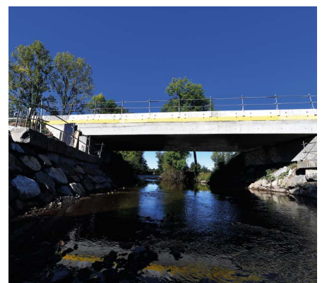
Chantier d'élargissement du pont sur la Jordanne
