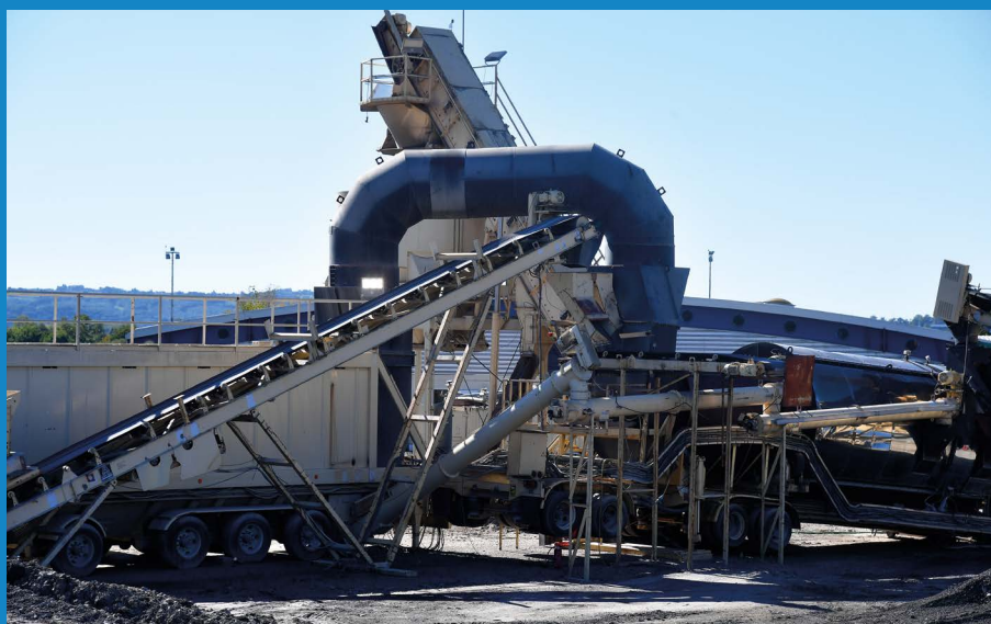
La centrale d'enrobés à Tronquières
