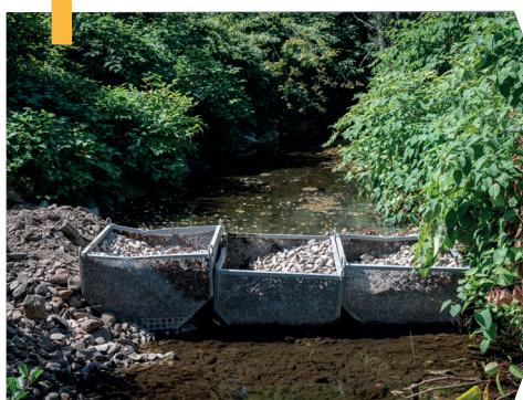
Des filtres à cailloux sont disposés en travers du lit, en amont et en aval de la zone de travaux pour empêcher les poissons d'y accéder.
