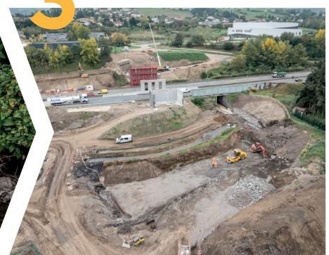
Une fois la zone asséchée, les travaux de terrassements et de réalisation de plateforme sont menés pour accueillir les ouvrages hydrauliques. Le cours d'eau est ensuite libéré dans son nouveau lit et passe par ces ouvrages.
