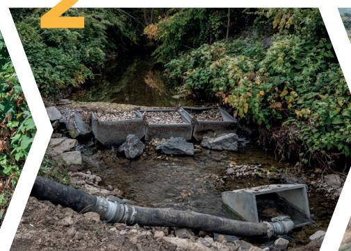
Des pompes sont déployées pour prélever l'eau en amont et la rejeter en aval. L'eau résiduelle de la zone intermédiaire est également pompée pour libérer le terrain.
