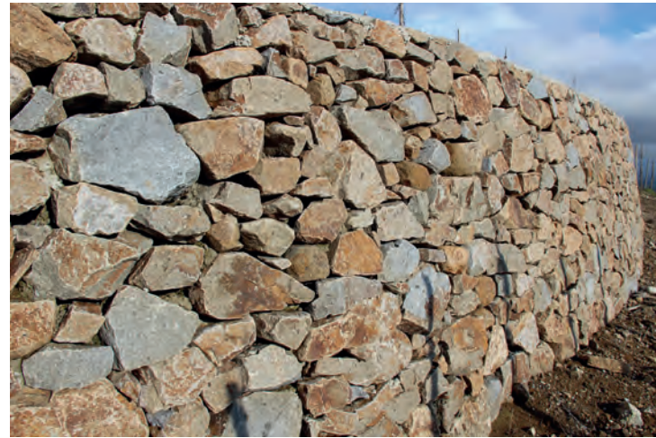
Les murs de soutènement en granit : technique en parement (Fiche 2.b)
