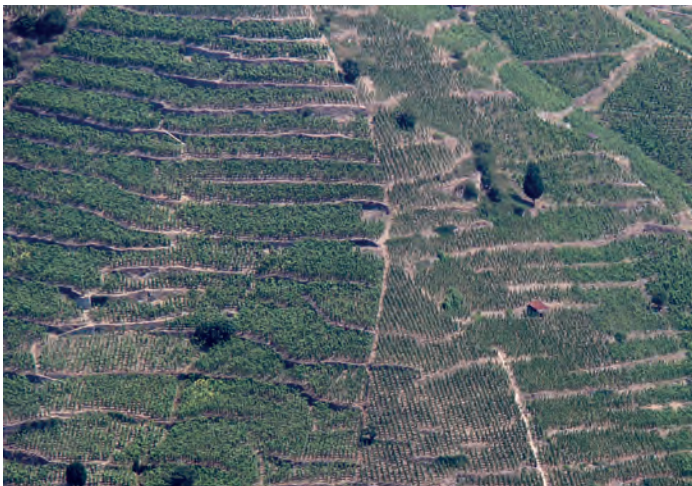
Murs de soutènement
