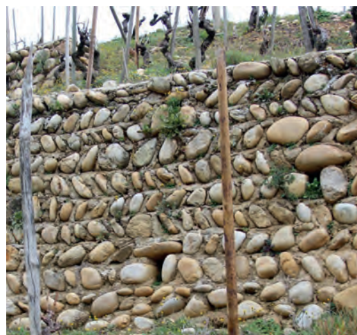
Mur en galets
