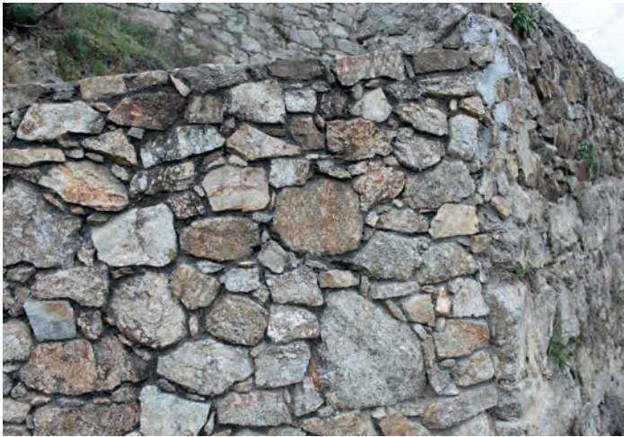
Les murs de soutènement en granit : technique en pierre sèche (Fiche 2.a)
