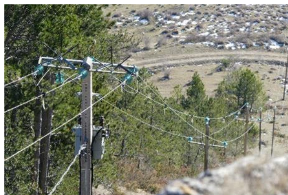
Figure 39: Equipement de la ligne à Fraissinet-de-Fourques. Pose de cieres et de balises Firefly. Léa GIRAUD©
