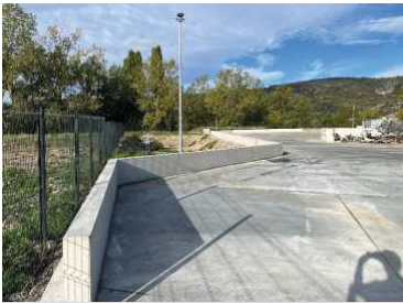
Plateforme SOLLUWASTE : angle sud-ouest de l'aire bétonnée, bassin de rétention/infiltration, vanne de fermeture en entrée du bassin et muret béton délimitant l'aire de rétention des eaux pluviales et des eaux d'extinction incendie (clichié TS 09/22)
