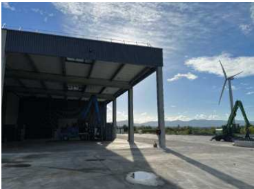
Plateforme SOLUWASTE : Bâtiment partie ouverte vu depuis l'aire bétonnée de stockage des déchets vers le sud-est (cliché TS 09/22)
