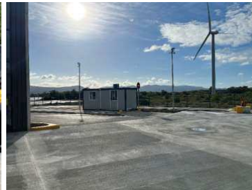
Plateforme SOLLUWASTE : la plateforme est totalement clôturée et équipée de mâts avec dispositif de vidéosurveillance en permanence (clichié TS 09/22)
