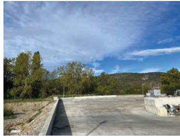
Plateforme SOLLUWASTE : angle sud-ouest de l'aire bétonnée, bassin de rétention/infiltration en cours d'enherbement et muret béton délimitant l'aire de rétention des eaux pluviales et des eaux d'extinction incendie (clichié TS 09/22)
