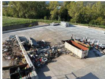
Plateforme SOLUWASTE : angle sud-ouest de l'aire bétonnée de stockage des déchets, bassin de rétention/infiltration et zone d'accueil de la presse-cisaille vus depuis le toit du bâtiment vers le sud-ouest (cliché TS 09/22)
