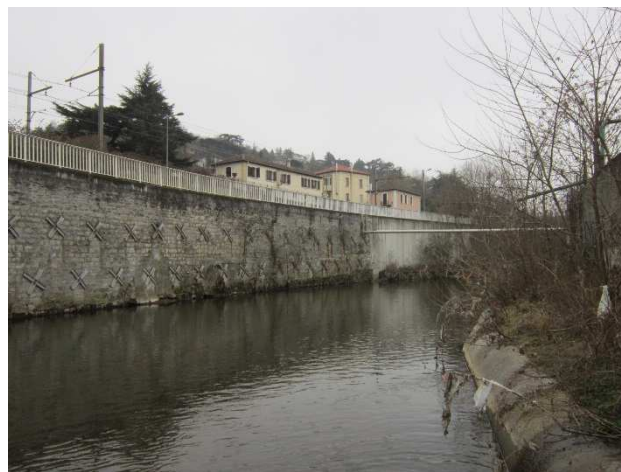
Rive droite : mur de soutènement amont de la rue du Gier
