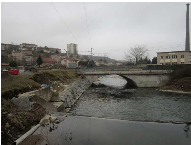
Rive gauche : enrochements aval
