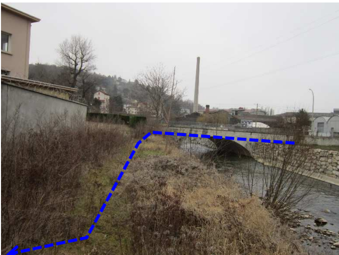
Principe d'implantation de la conduite de refoulement d'eau brute- Variante B
