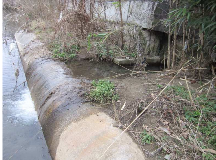
Collecteur d'assainissement Ø1200 en rive gauche
