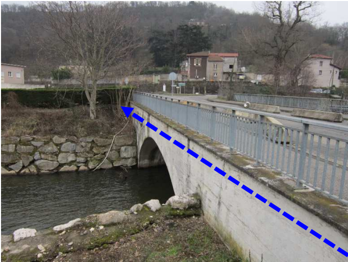
Principe d'implantation de la conduite de refoulement d'eau brute- Variante A
