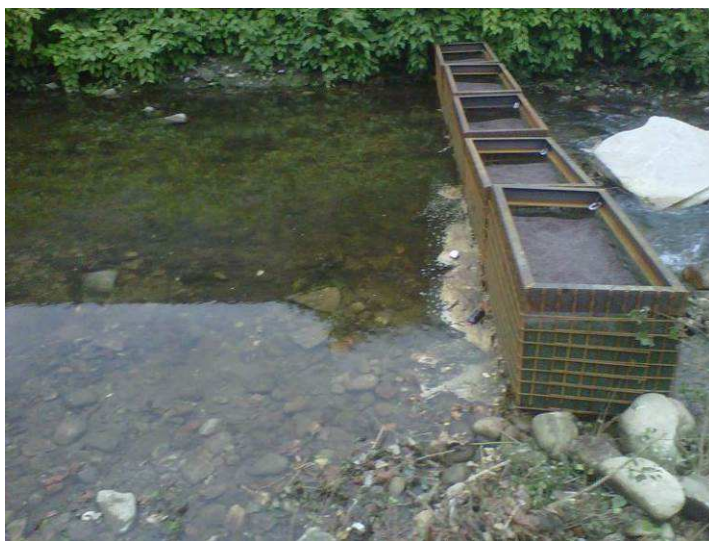
Filtre à MES (cage métallique avec pouzzolane)
