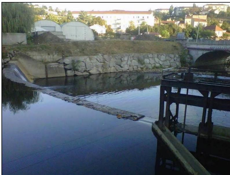
*Photographie du seuil depuis l'amont rive droite et vue sur la prise d'eau*
