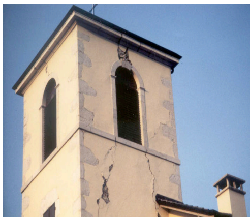
Dommages observés lors du séisme d'Epagny (Annecy, 1996). Le montant des dommages a été estimé à 50 million d'euros.
