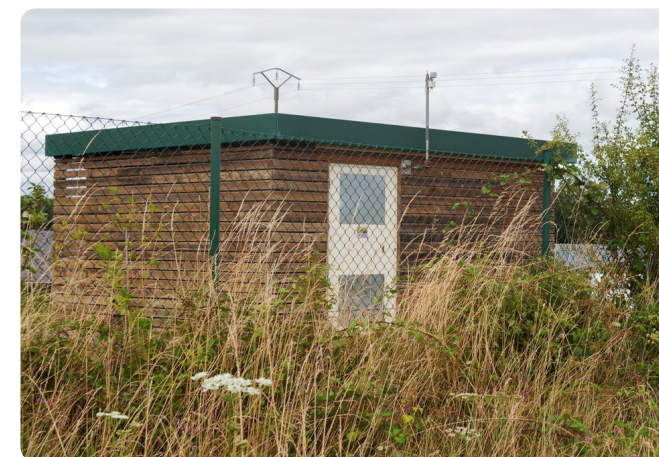
Poste existant sur le site du Parc de Gennetines
