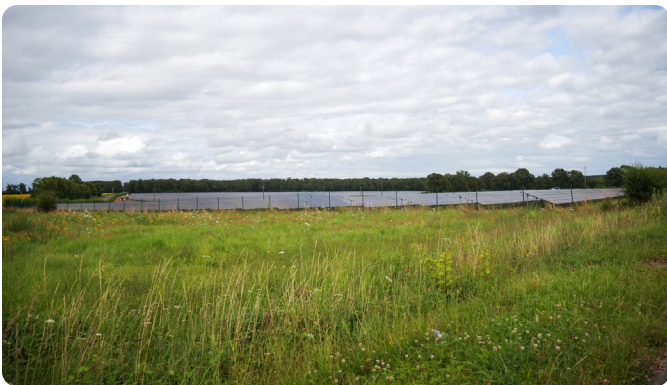
Parc photovoltaïque existant à proximité de Gennetines
